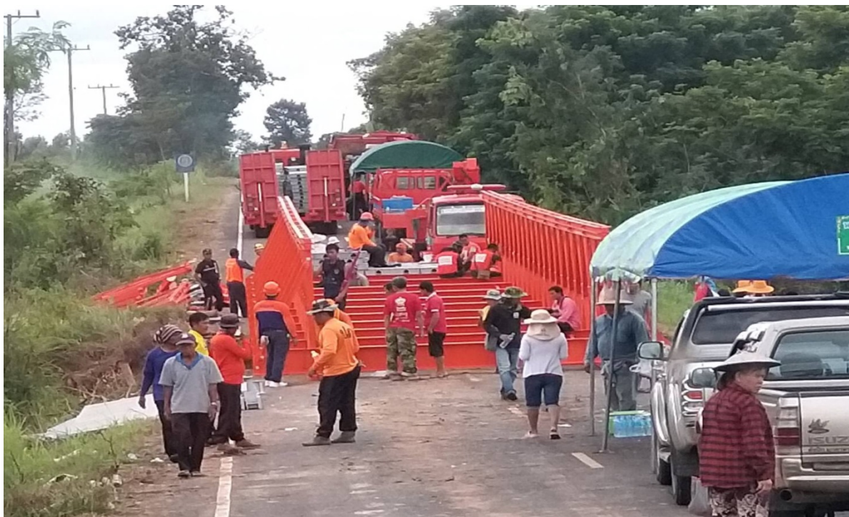
การติดตั้งสะพานเบลีย์ของศูนย์ป้องกันและบรรเทาสาธารณภัย เขต ๗ สกลนคร บนทางหลวงชนบทสาย มท. ๓๐๑๖ เส้นทางสายด้านดงมัน - บ้านนาโพธิ์ ช่วงบ้านนายอ - บ้านป่าพยอม บริเวณบ้านป่าพยอม ตำบลเหล่าหมี อำเภอดอนตาล จังหวัดมุกดาหาร ระหว่างวันที่ ๒ - ๘ กันยายน ๒๕๖๒
