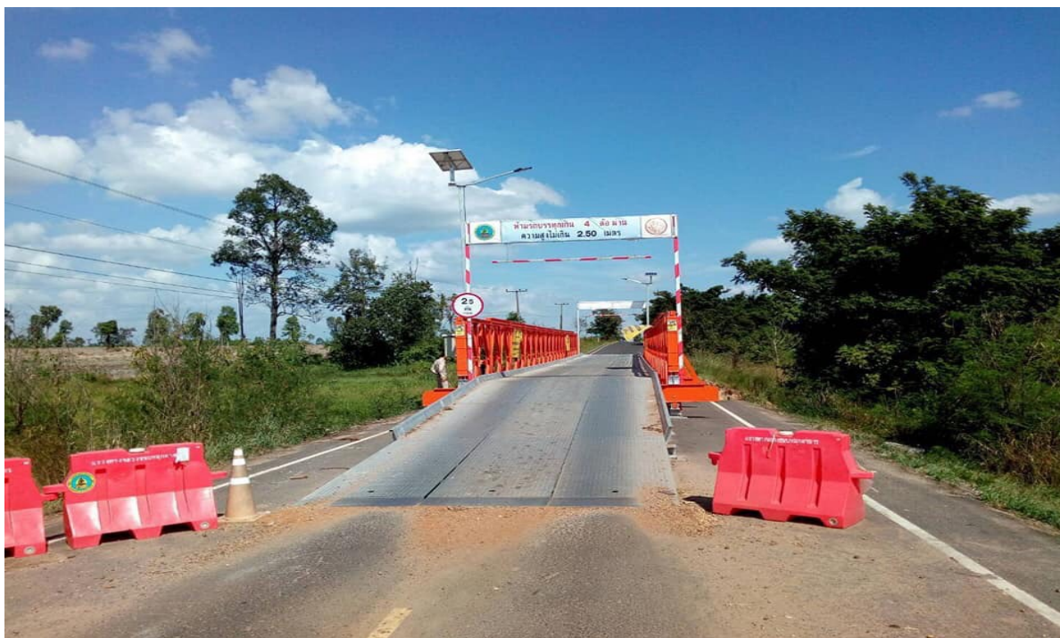
การติดตั้งป้ายเตือนสะพานเบลีย์ บนทางหลวงชนบทสาย มท. ๓๐๑๖ เส้นทางสายด้านดงมัน - บ้านนาโพธิ์ ช่วงบ้านนายอ - บ้านป่าพยอม บริเวณบ้านป่าพยอม ตำบลเหล่าหมี อำเภอดอนตาล จังหวัดมุกดาหาร
