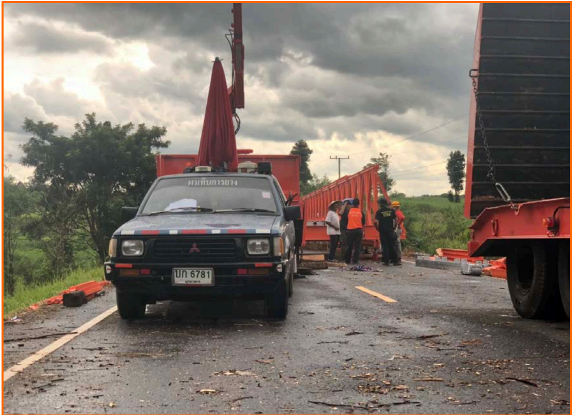
จิตอาสาหาที่บริการยางมาช่วยเจ้าหน้าที่ติดตั้งสะพานแบลีย์บริเวณถนนสายบ้านนายอ - บ้านป่าพยอม ตำบลเหล่าหมี อำเภอดอนตาล จังหวัดมุกดาหาร ระหว่างวันที่ ๒ - ๘ กันยายน ๒๕๖๒
