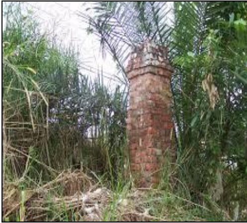
ปล่องหุงต้มอดีตทัณฑนิคมธารโต
