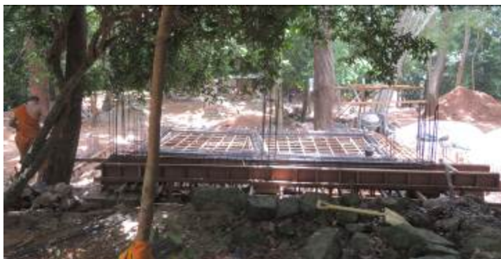
ฐานบันไดที่มีการวางฐานราก
