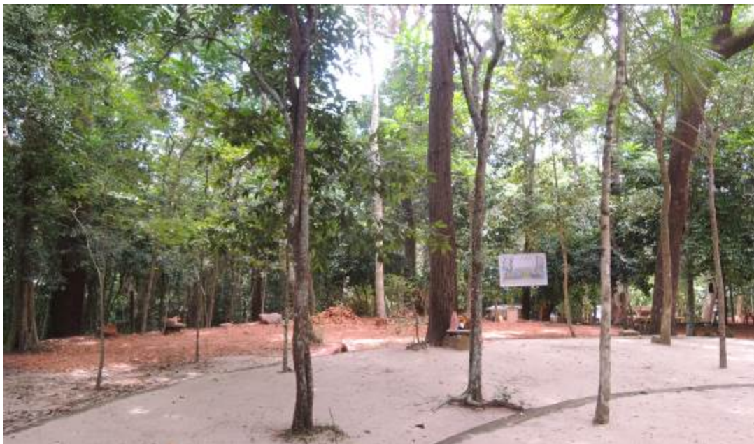
พื้นที่ทำการบูรณะปรับปรุงใหญ่ คือชั้นรองลงมาจากลานพระอุโบสถชั้นบน (ด้านซ้ายมือที่เห็นดินแดงมอยู่)
