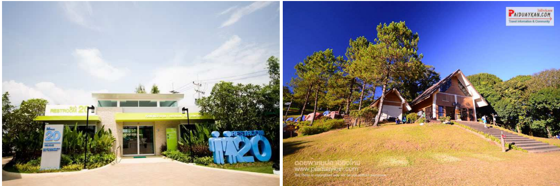
ภาพที่ 7 โครงสร้างพื้นฐาน ระบบสาธารณูปโภค
