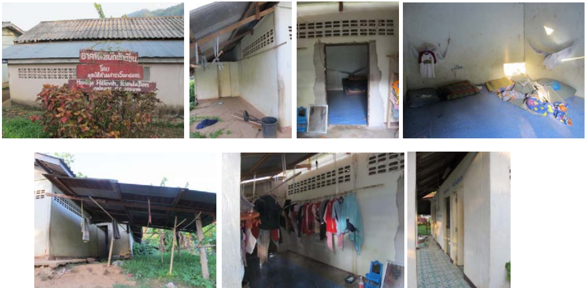
บริเวณหอพักนักเรียน : ห้องแถว 1 ชั้น แบ่งสองฝั่งนักเรียนชายและนักเรียนหญิง ใช้ห้องน้ำบริเวณภายนอกอาคาร หรือห้องน้ำรวมด้านนอก มีเป้าหมายในการปรับปรุง ปรับภูมิทัศน์
