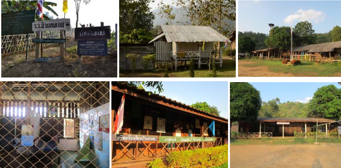
บริเวณโรงเรียนบ้านสบเมย : ห้องสมุด อาคารเรียน ห้องพยาบาล อาคารเอนกประสงค์
