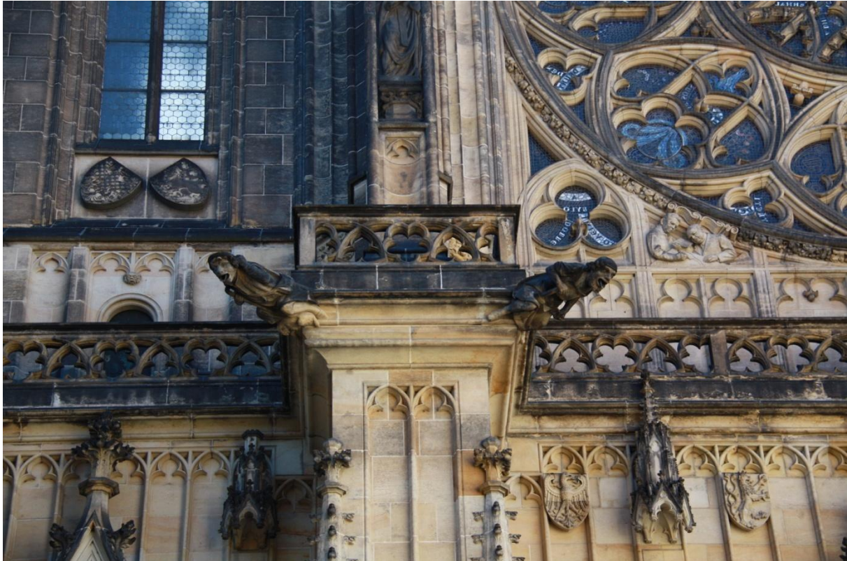
การก่อยล สัตว์ประหลาดที่เป็นปากท่อต่อจากรางน้ำฝน กันน้ำฝนให้พื้นผนัง
