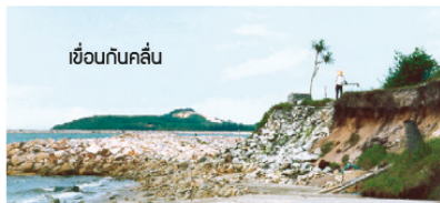
ภาพที่ 15 การเสียสมดุลของหาดทรายเนื่องจากเขื่อนกันทรายที่ปากคลองสะกอมส่งผลให้เกิดการกัดเซาะที่บ้านบ่อไซน การแก้ปัญหาด้วยการสร้างเขื่อนกันคลื่นที่บ้านบ่อไซน ทำให้หาดทรายพังทลายเป็นแนวตลอดชายฝั่ง อำเภอจะนะ จังหวัดสงขลา
