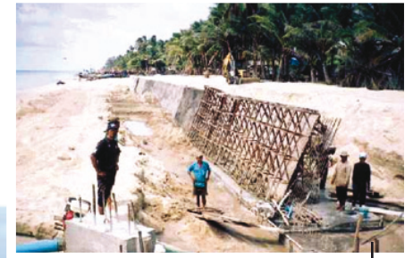
ภาพที่ 13 เขื่อนกันทรายและเขื่อนกันคลื่นที่ปากคลองระบายน้ำชะอวด-แพรกเมือง ทำให้เกิดการกัดเซาะไปทางเหนือ จากนั้นมีการแก้ปัญหาด้วยการสร้างกำแพงกันคลื่นที่บ้านหน้าศาล อำเภอหัวไทร ที่มา : (ปรีทัศน์ เจริญสิทธิ์. 2550) และสมบุญ พรพิเนตพงศ์ 2550
