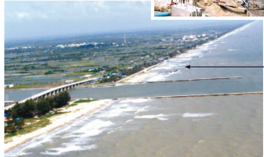
ภาพที่ 13 เขื่อนกันทรายและเขื่อนกันคลื่นที่ปากคลองระบายน้ำชะอวด-แพรกเมือง ทำให้เกิดการกัดเซาะไปทางเหนือ จากนั้นมีการแก้ปัญหาด้วยการสร้างกำแพงกันคลื่นที่บ้านหน้าศาล อำเภอหัวไทร ที่มา : (ปรีทัศน์ เจริญสิทธิ์. 2550) และสมบุญ พรพิเนตพงศ์ 2550
